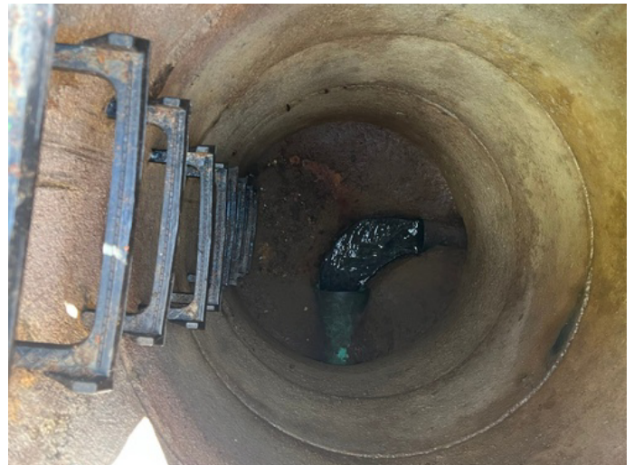
Manhole: K-6 Depth: 11ft
