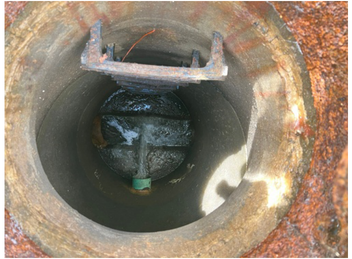
Manhole: K-2 Depth: 10ft
